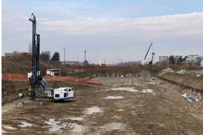
Gli scavi per la galleria della Cassanese Bis che attraverserà via Morandi
