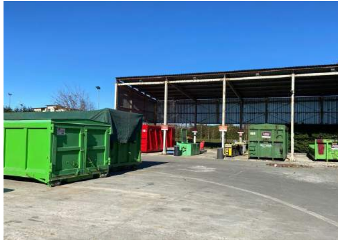
Qui sopra, i cassoni per i rifiuti nel piazzale della struttura
