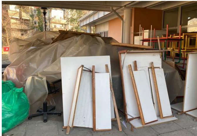
Qui sopra, gli arredi accastati fuori dalla scuola dell'infanzia in attesa del trasloco che avverrà alla chiusura del cantiere
