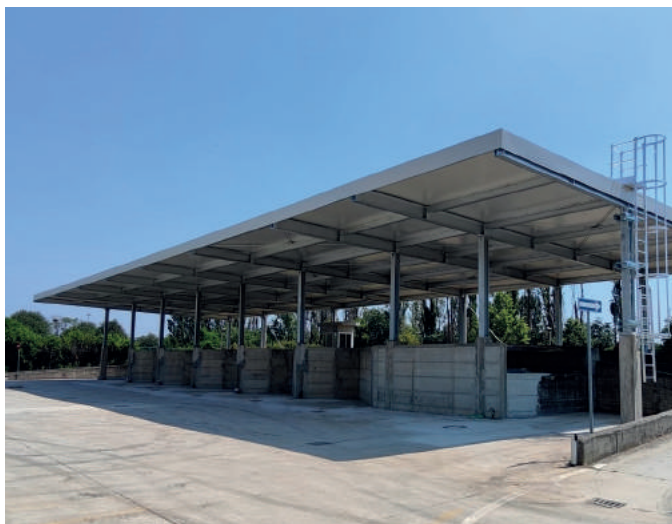
Qui sopra, la piattaforma ecologica riqualificata con i fondi del Piano Lombardia: è rimasta chiusa per circa sette mesi
