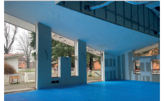
IL GRANDE SALONE POLIFUNZIONALE Sembra il fondo di una piscina, ma è il materiale isolante posato sul pavimento. Qui il salone affacciato sul cortile interno.
