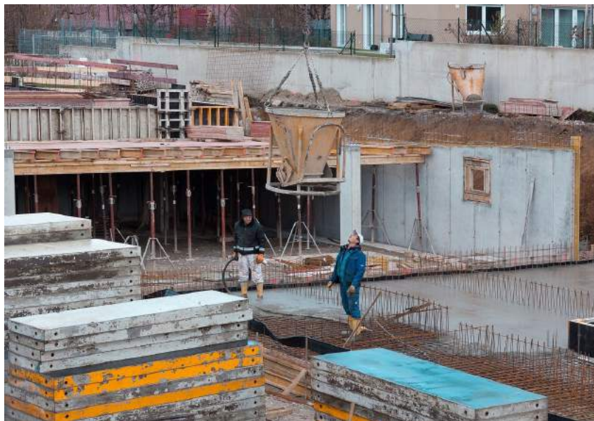
Operai in un cantiere edile (Archivio). In basso, Andrea Peregò (Fillea-Cgil)
