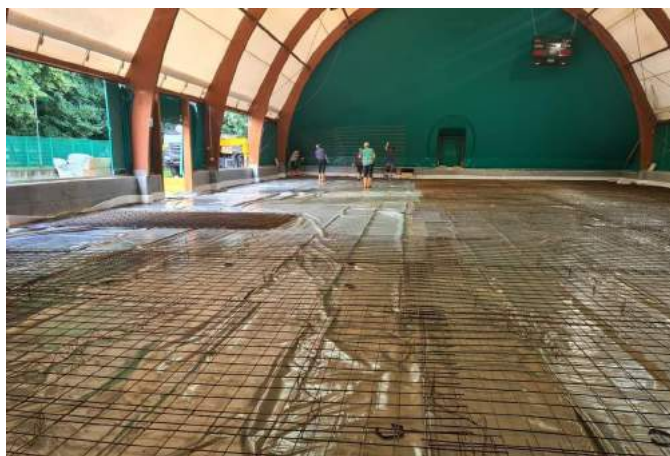
Qui sopra, il rifacimento della pavimentazione del campo
