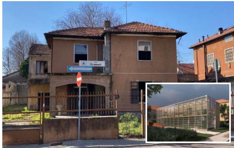
Sopra, le villette abbandonate di via Gramsci sulle quali è previsto un progetto di "housing first" finanziato in parte dal PNRR (vedi riquadro)
