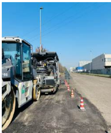
I lavori in corso per la riasfaltatura della strada, a Milano Oltre
