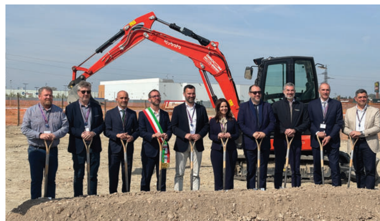
Qui sopra, manager di CyrusOne e autorità (al centro Paolo Micheli) all'inaugurazione del cantiere per la costruzione del nuovo complesso tecnologico. A sinistra foto dei lavori di sbancamento dell'area ex Cise
