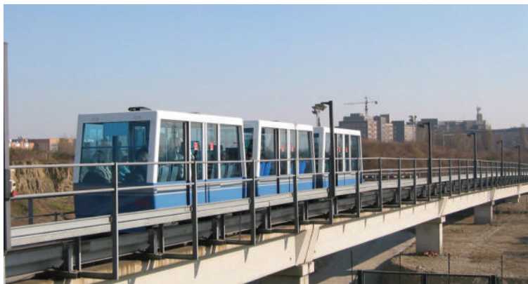
Nella foto sopra la Metro Leggera Automatica (MeLa) che era in servizio tra la fermata Cascina Gobba e l'ospedale (foto E. Palermi)
