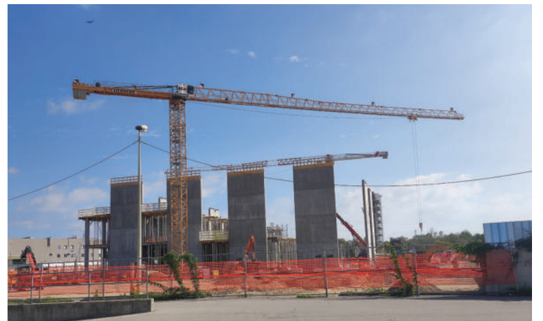
Lo stato attuale del cantiere MIL1 nel quartiere di Redecesio. L'edificio in costruzione dovrebbe entrare in esercizio a metà 2027
