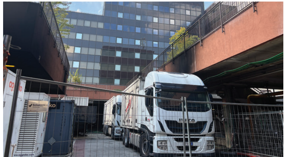
I tir con i generatori sotto il centro direzionale. Si vede il nero lasciato dai fumi
