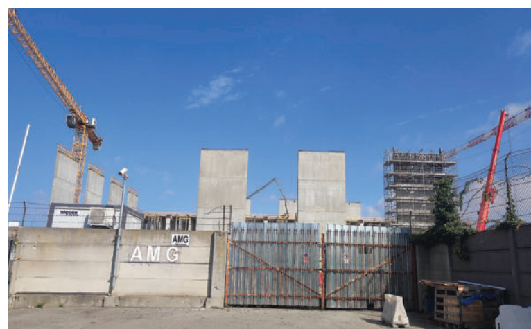
Qui sopra, il cantiere per la costruzione del data center di Segrate ad opera di CyrusOne a Redeciesio. Al momento si sta lavorando al primo edificio, ma il masterplan ne prevede due per un totale di 63MW
